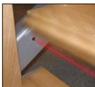
Os sensores infravermelhos evitam situações de esmagamento entre degraus.
